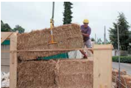
ECO-46 en chantier: pose des bottes de paille.
