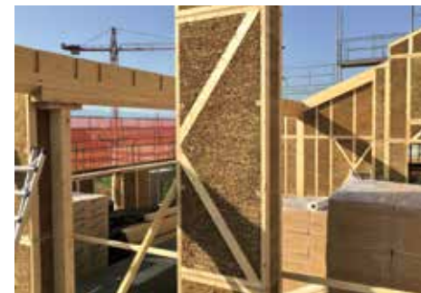
Modules préfabriqués bois/paille EcoCocon (© SHIFT)
