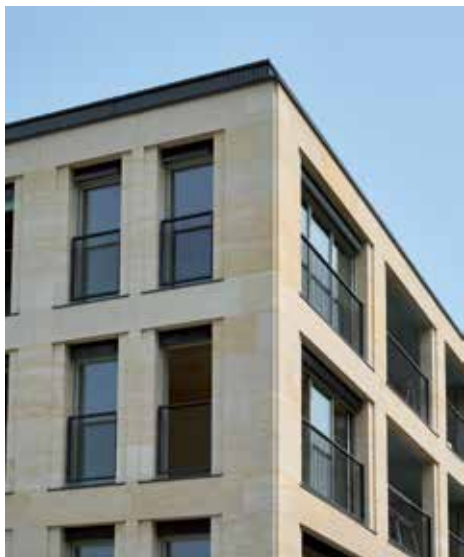
Immeuble pierre et bois la Coulouvrenière, Genève (© Atelier Archiplein – Leo Fabrizio)
