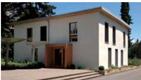
ECO-46, une construction qui abrite l'administration des parcs et domaines de la Ville de Lausanne. De l'extérieur, rien ne la différencie visuellement des autres bâtisses, malgré une construction en bottes de paille porteuse. (© 2014 Noé Cauderay)
